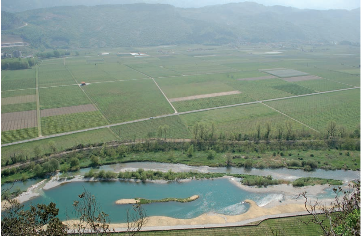
FIGURA 10 – Rinaturalizzazione di un tratto dell'alveo del Fiume Sarca (Pietramurata).
