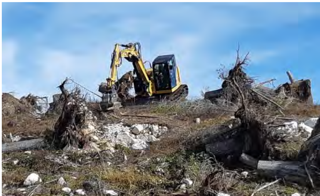
Fig.14.5 Preparazione del terreno con escavatore e fresa (fonte: UDF Borgo V.).
