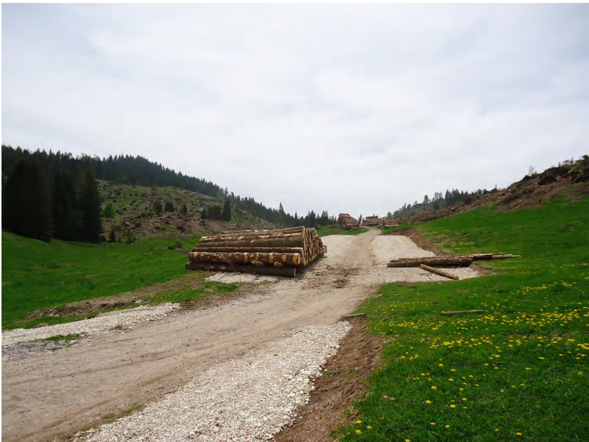
Fig.11.6 Realizzazione di un nuovo piazzale locale (Val Brutta) nel Comune di Grigno (fonte: UDF Borgo Valsugana).
