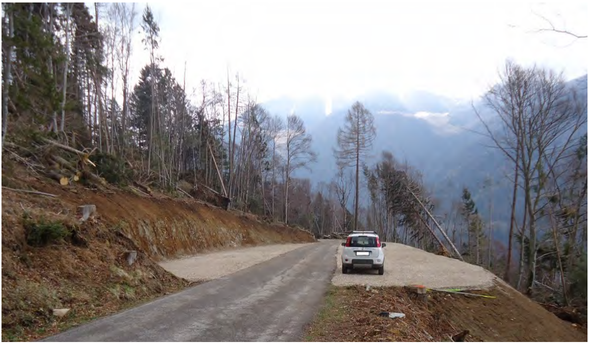
Fig.11.5 Realizzazione di un nuovo piazzale locale (Marana) nel Comune di Telve (fonte: UDF Borgo Valsugana).
