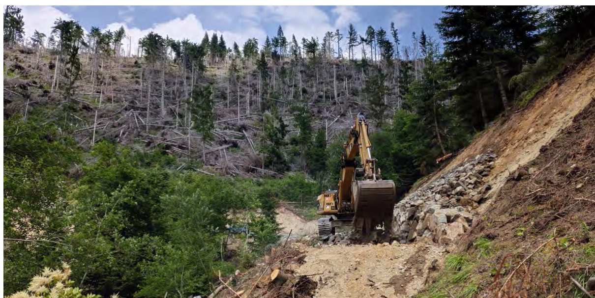
Fig 10.6 Collegamento di strade forestali esistenti al fine di agevolare il recupero ed esbosco del legname schiantato (fonte: UDF Pergine Valsugana)
