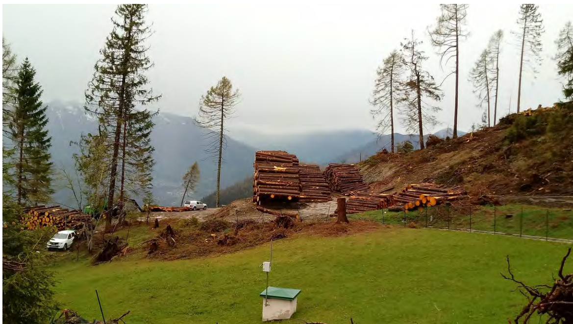
Fig.11.11 Adeguamento piazzale locale in loc. Vetriolo nel Comune di Levico Terme (fonte: UDF Pergine V.
