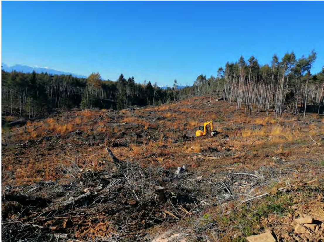
Fig.14.23 Preparazione del terreno con escavatore (fonte: Mattia Piva – Servizio Foreste).
