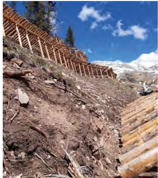
Fig.13.3 Paravalanghe eseguiti sul versante schiantato al di sopra dell'abitato di Pampeago, tra un paravalanghe e l'altro sono stati realizzati gli impianti (foto: Andrea Carbonari - APROFOD ).
