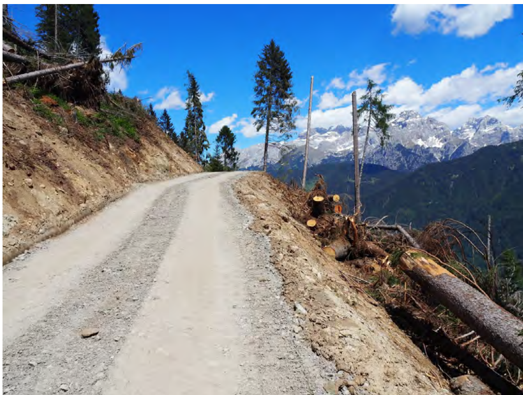
Fig 10.9 Realizzazione di una nuova strada forestale nel Comune di Strembo (fonte: UDF Tione).
