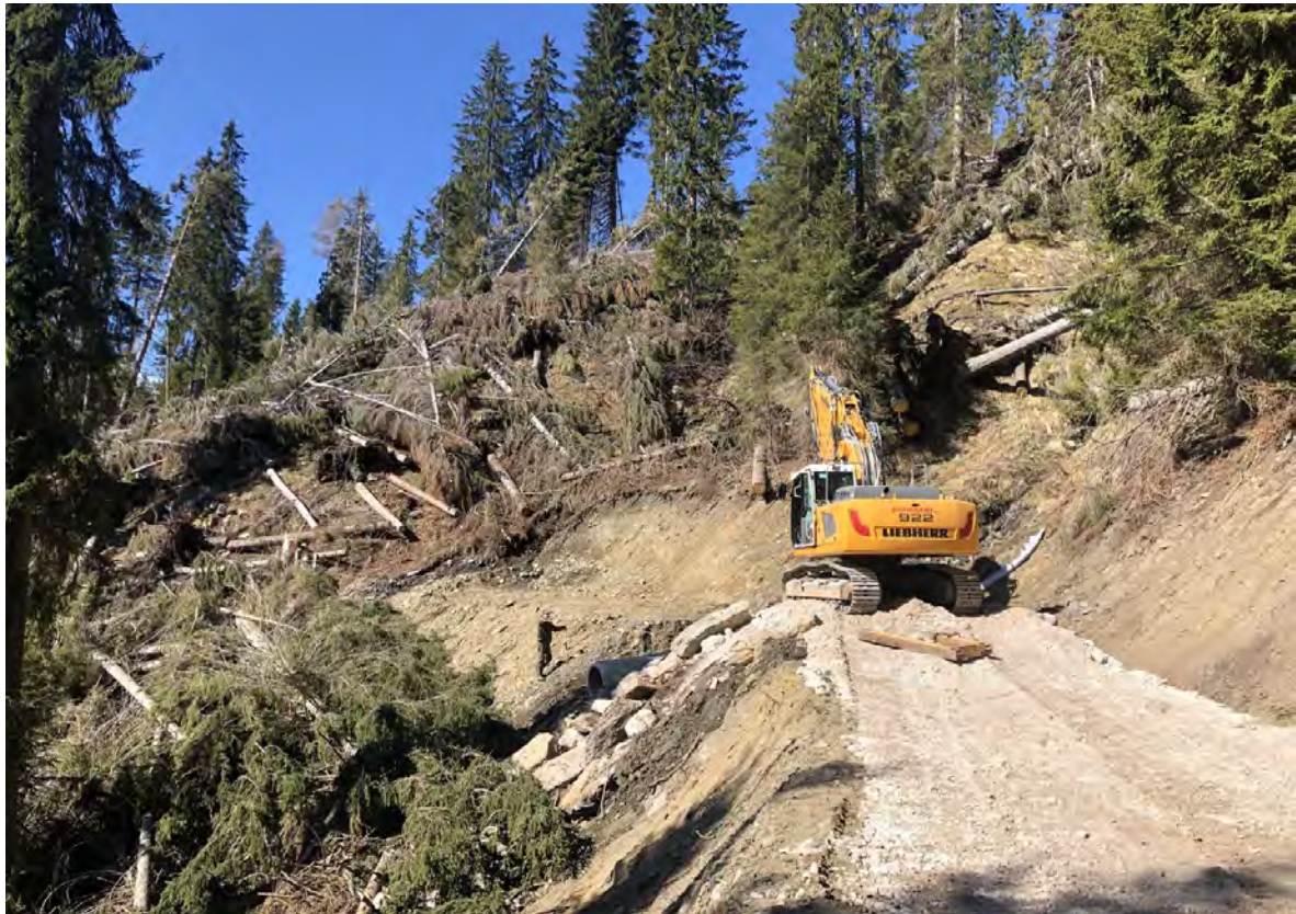
Fig.10.3 Realizzazione di una nuova strada forestale a Primiero (fonte: UDF – Primiero).
