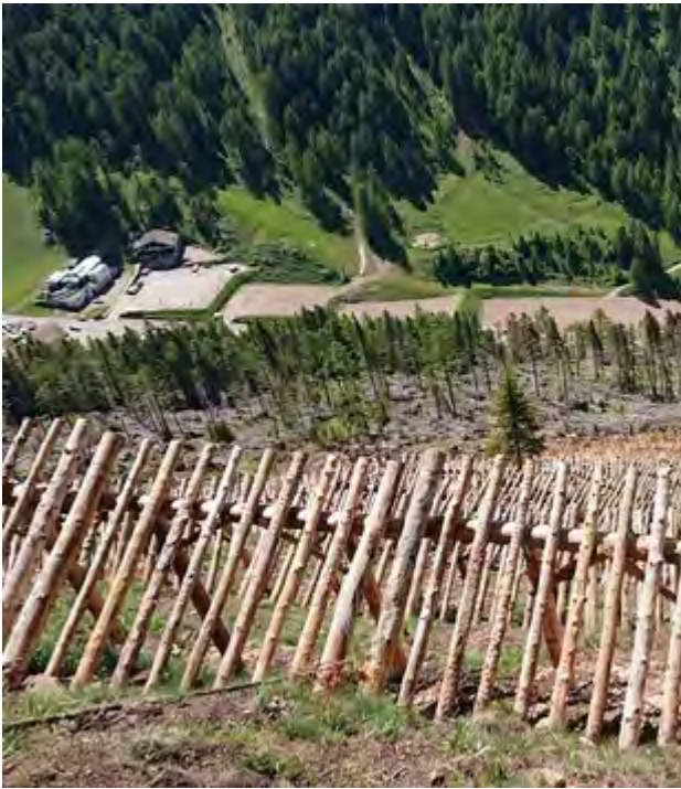
Fig.13.3 Paravalanghe eseguiti sul versante schiantato al di sopra dell'abitato di Pampeago, tra un paravalanghe e l'altro sono stati realizzati gli impianti (foto: Andrea Carbonari - APROFOD ).
