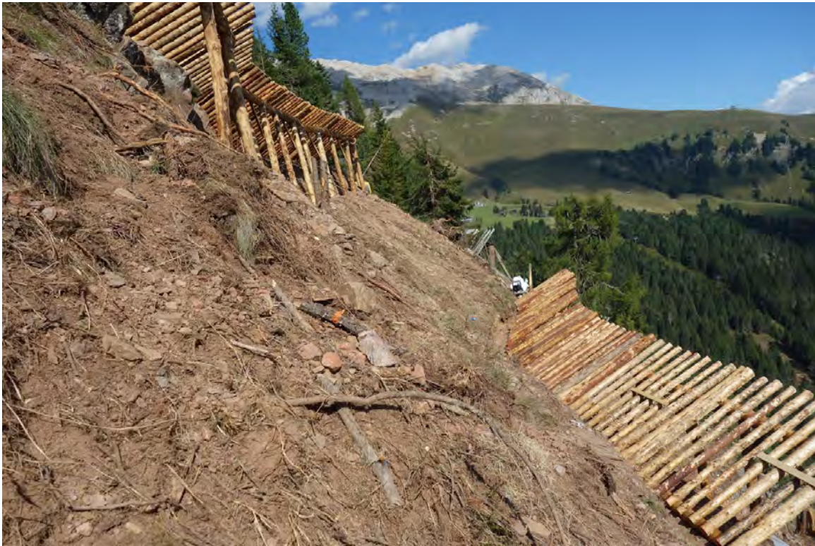
Fig.14.17 Paravalanghe di recente realizzazione nell'area campione "Pampeago"(fonte: Andrea Carbonari – APROFOD).
