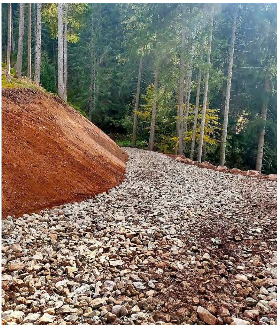
Fig 10.5 Realizzazione di una nuova strada forestale a Baselga di Pinè, loc. Campolongo (fonte: archivio Servizio Foreste)
