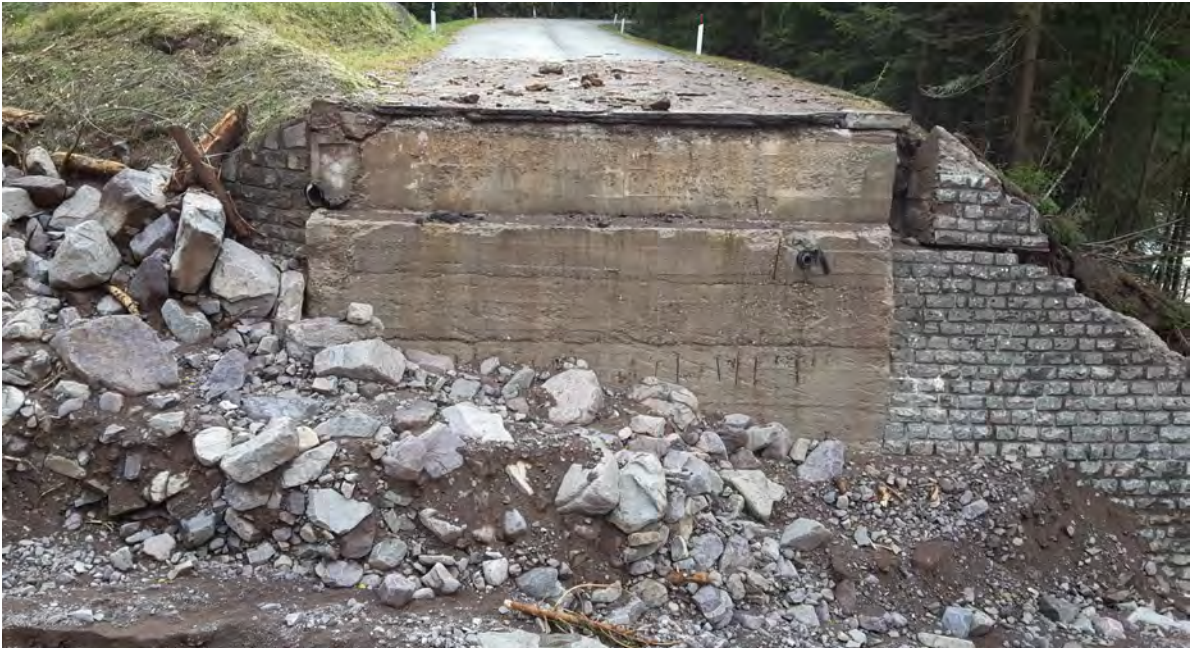
Fig. 10.1 Cedimento sulla SP 31 del Passo Manghen (fonte: archivio APROFOD).
