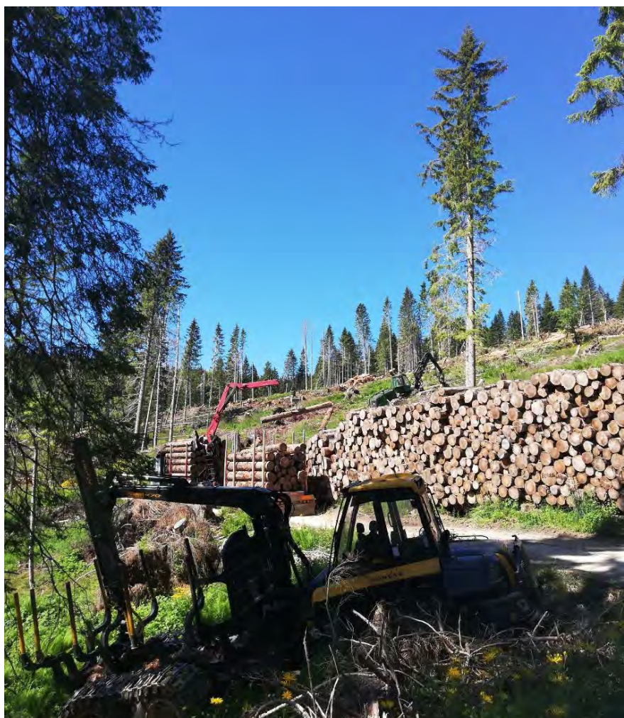
Fig. 8.1 Cantiere forestale in area schiantata nel Comune di Folgaria (fonte: Luca Sordo – Servizio Foreste).
